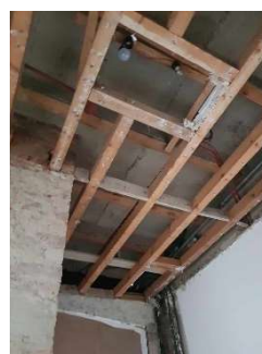
Photos prises sur chantier le 22 juin 2023. On peut y voir : Les linteaux posés et le faux plafond dans l'entrée démolie, ainsi que le travail réalisé par l'entreprise de plomberie.
