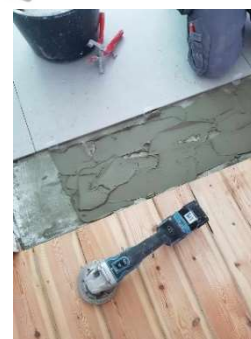
Photos prises sur chantier le 23 juin 2023. On peut y voir : une ponceuse à bande, le mortier-colle en poudre pour la pose de carreaux en céramique, sa préparation et la pose des carreaux.
