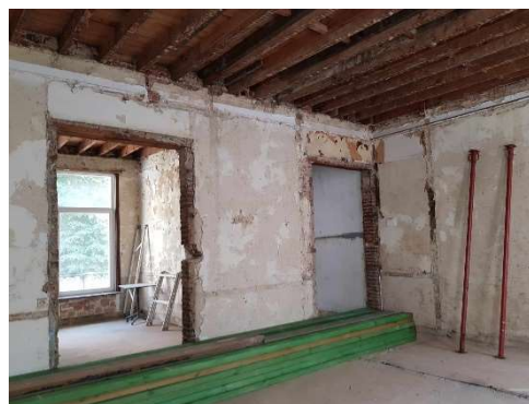
Photos prises sur chantier le 15 juin 2023. On peut y voir : Des déchets des précédents jours de démolition, les gites et les panneaux OSB au rez-de-chaussée (au centre) et les gites montés au premier étage (à droite).
