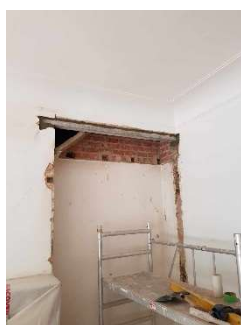
Photos prises sur chantier le 22 juin 2023. On peut y voir : Les linteaux posés et le faux plafond dans l'entrée démolie, ainsi que le travail réalisé par l'entreprise de plomberie.
