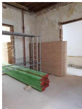
Photos prises sur chantier le 15 juin 2023. On peut y voir : Des déchets des précédents jours de démolition, les gites et les panneaux OSB au rez-de-chaussée (au centre) et les gites montés au premier étage (à droite).
