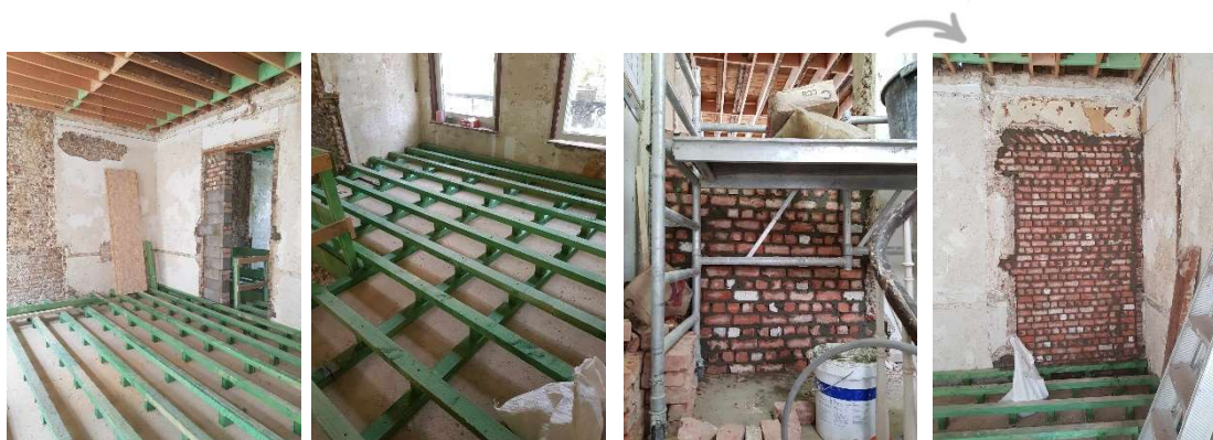
Photos prises sur chantier le 30 juin 2023. On peut y voir : La mise à niveau du sol avec des lambourdes et des cales au premier étage et le maçonnerie d'une ancienne ouverture au premier étage, une vue depuis la cage d'escalier et une depuis le futur logement.
