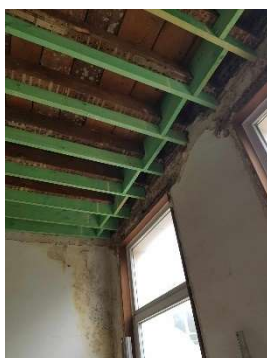
Photos prises sur chantier le 29 juin 2023. On peut y voir : L'ancienne trémie de cheminée rebouchée par des panneaux OSB, le chainage de la petite pièce du second étage (à gauche) et l'évolution de la mise à niveau du sol avec des cales et des lambourdes.
