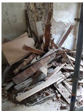
Photos prises sur chantier le 15 juin 2023. On peut y voir : Des déchets des précédents jours de démolition, les gites et les panneaux OSB au rez-de-chaussée (au centre) et les gites montés au premier étage (à droite).
