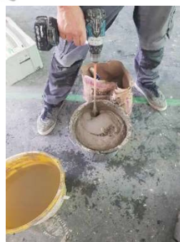
Photos prises sur chantier le 23 juin 2023. On peut y voir : une ponceuse à bande, le mortier-colle en poudre pour la pose de carreaux en céramique, sa préparation et la pose des carreaux.
