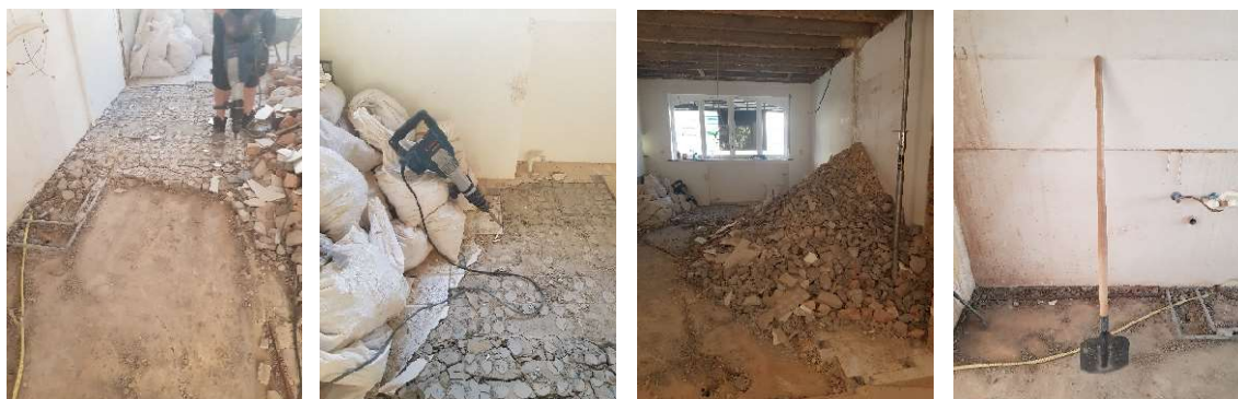
Photos prises sur chantier le 12 juin 2023. On peut y voir : La chape entrain d'être démolie au marteau piqueur, un marteau piqueur, le tas de déchets des démolitions évacué dans le container en fin de journée et une pelle.
