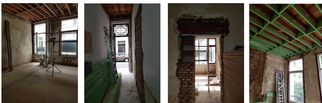
Photos prises sur chantier le 28 juin 2023. On peut y voir : Une vue du premier étage, les gites entreposés dans le couloir avant d'être déplacés dans le jardin et l'ouverture maçonné par Elmas, ainsi que le chainage au second étage.
