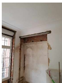
Photos prises sur chantier le 22 juin 2023. On peut y voir : Les linteaux posés et le faux plafond dans l'entrée démolie, ainsi que le travail réalisé par l'entreprise de plomberie.
