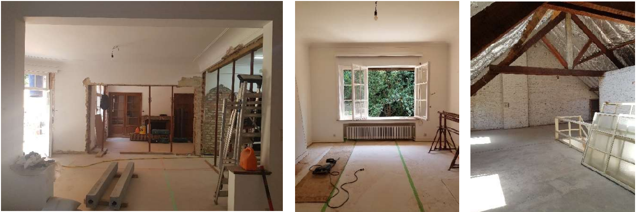
Photos prises sur chantier le 12 juin 2023. On peut y voir : la cage d'escalier et l'entrée depuis le premier salon, une vue de la cuisine depuis la salle à manger (page 6), une vue des salons depuis la salle à manger, une vue de la chambre parentale et des combles (ci-dessus).
